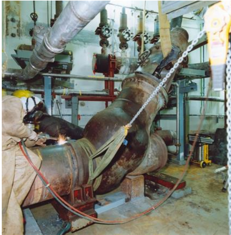
Abbildung 20: Autogenes Brennschneiden einer Absperrarmatur
