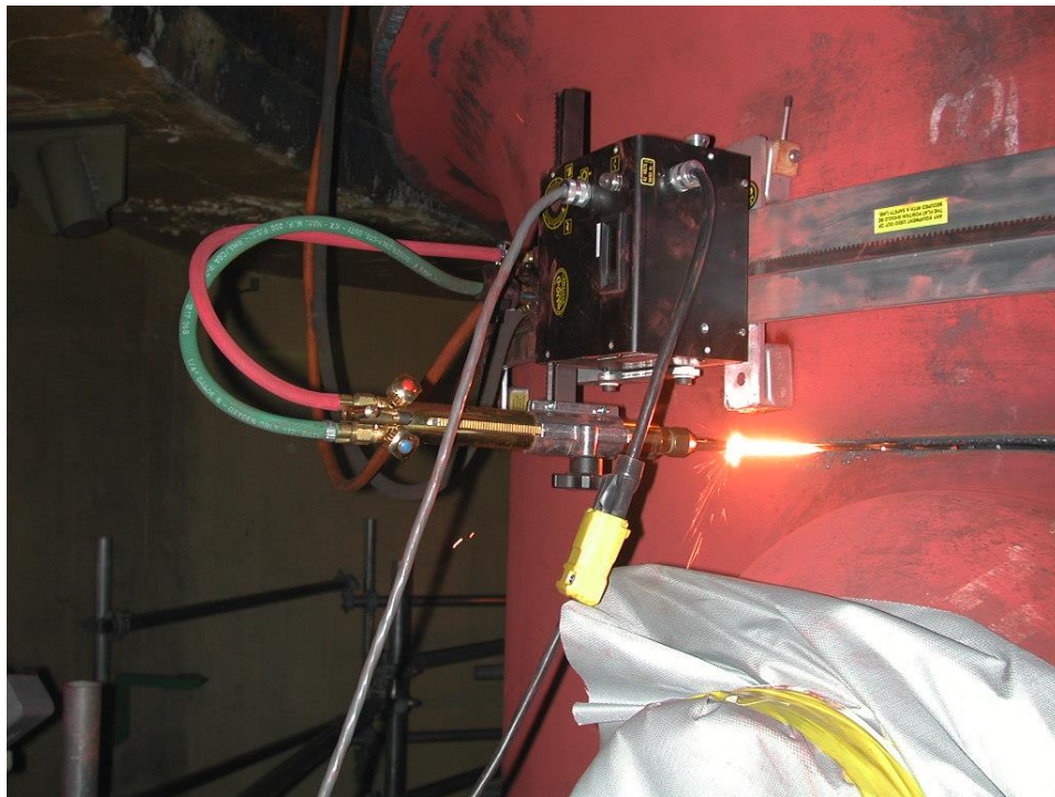
Abbildung 22: Zerlegen des Reaktordruckgefäßes in KRB A durch autogenes Brennschneiden
