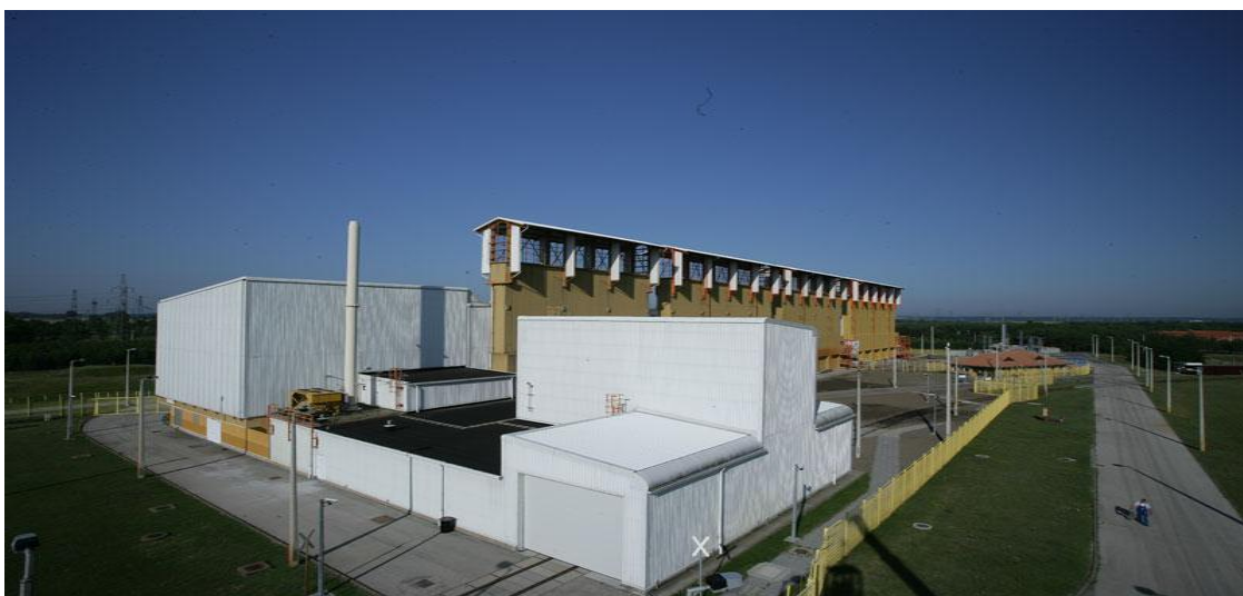
Obr. 8 Kompletné skladovacie zariadenie v JE Paks (RHK, 2009)
