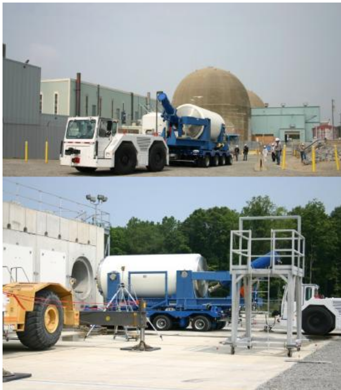
Obr. 20 Systém NUHOMS v JE Medzamor (AREVA, 2011)
