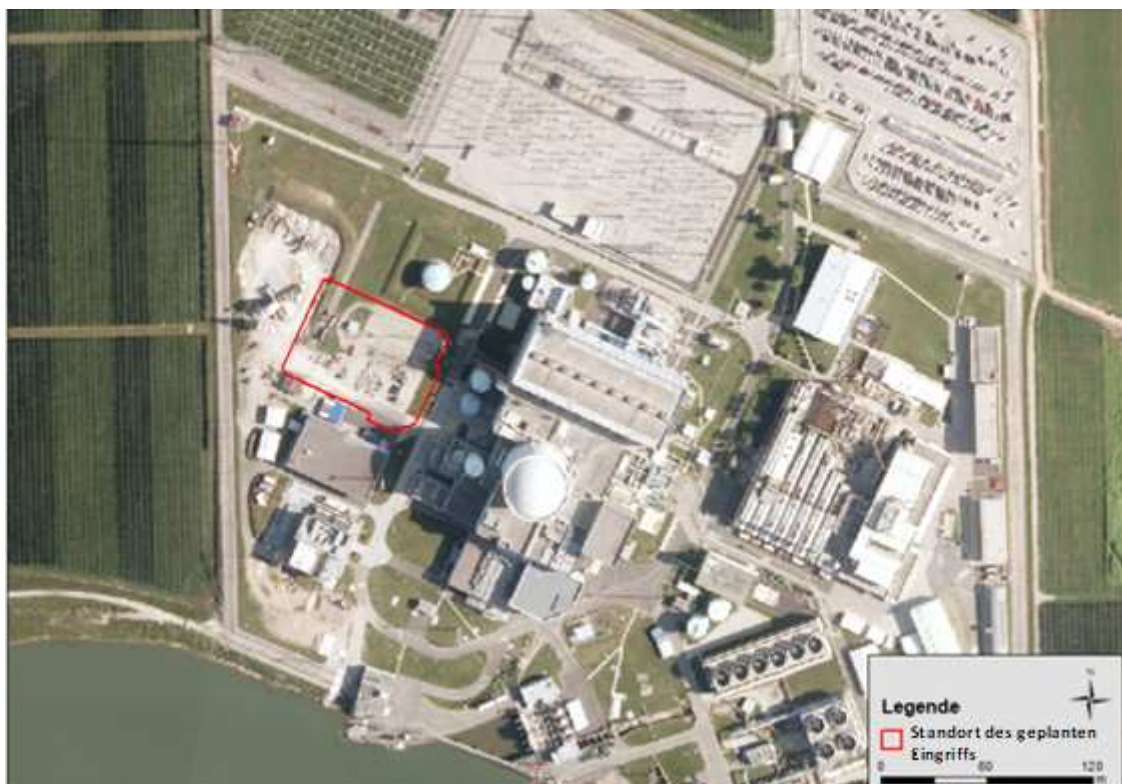
Abbildung 1: Standort des Trockenlagers mit Arbeitsplattform auf einem Orthofoto
