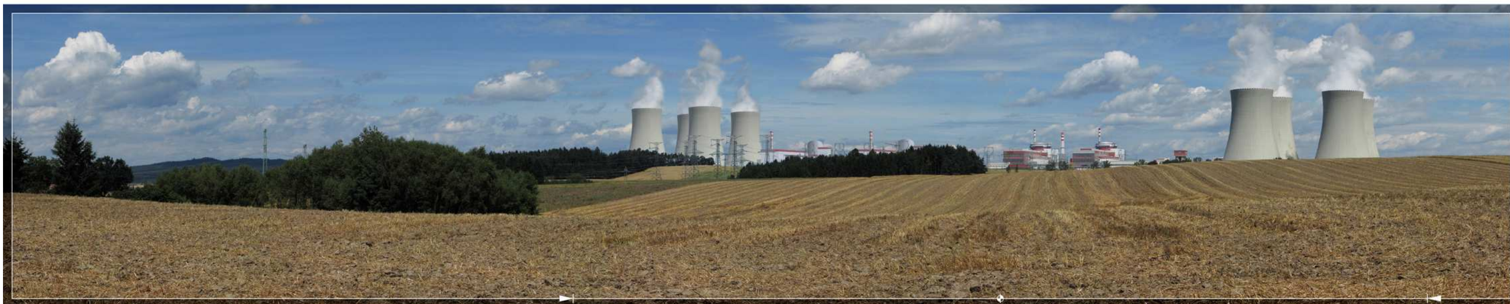
Bild 10.03: Korridor zur Ableitung der Generatorleistung vom östlichen Rand der Gemeinde Kočín aus (KKW Temelin dargestellt in Variante K); Panorama von S–SO aus einer Entfernung von 700–2 100 m
