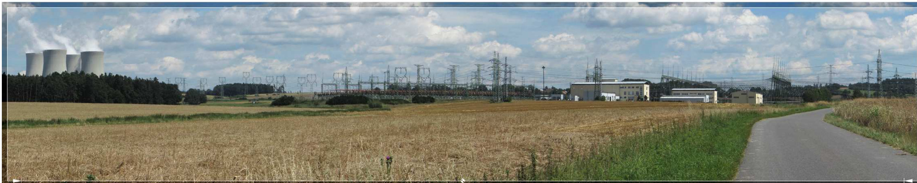
Bild 10.01: Gesamtansicht des Umspannwerkes Kočín und des Korridors zur Ableitung der Generatorleistung aus dem KKW Temelin (inkl. geplanter Ableitung der Generatorleistung aus der neuen KKA) von der Straße Kočín–Malešice aus (Blick von W–SW aus einer Entfernung von 750–2 500 m)
