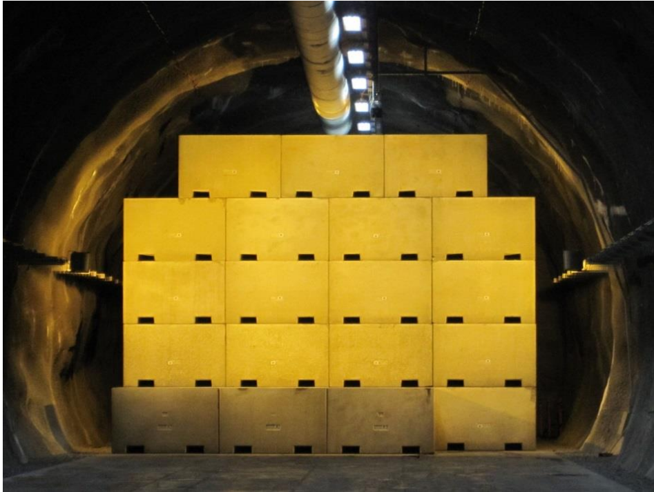
15. ábra: Vasbeton konténerek elhelyezése az NRHT I-K1 tárolókamrájában
