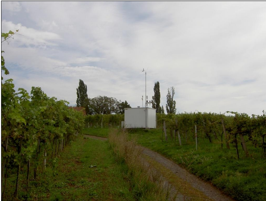
Abbildung 4: Messstelle Klösch von Südwesten. (© Umweltbundesamt/ Sarny)
