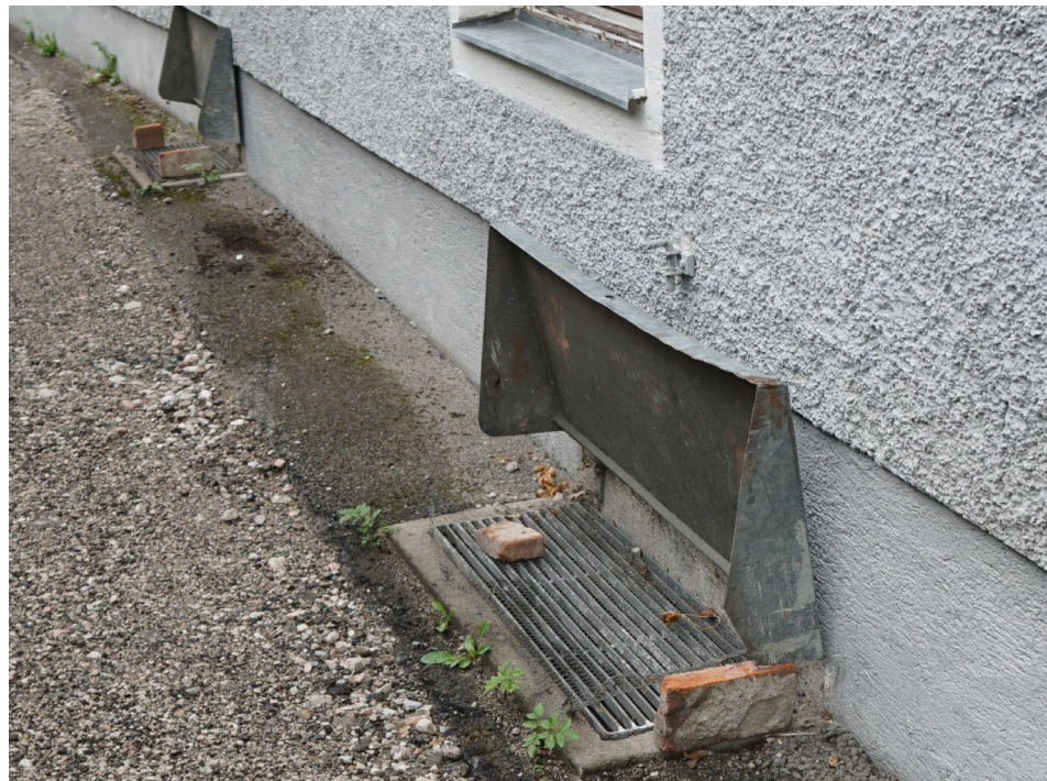
Abbildung 3: Eigenvorsorge – Abdichten der Kelleröffnung (© ILAP 2017)
