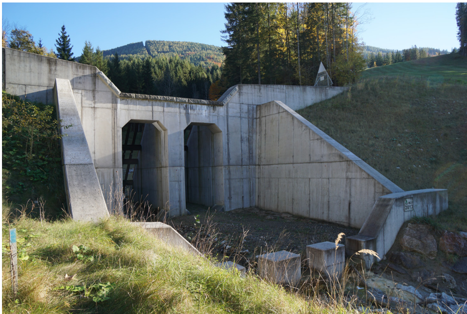
Abbildung 2: Öffentlicher Hochwasserschutz, Geschiebesperre (© ILAP 2018)
