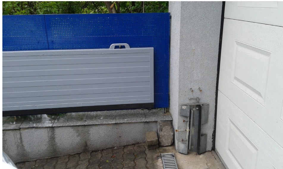
Abbildung 7: Mobiler Hochwasserschutz im Triestingtal (© UMWELTBUNDESAMT 2017)
